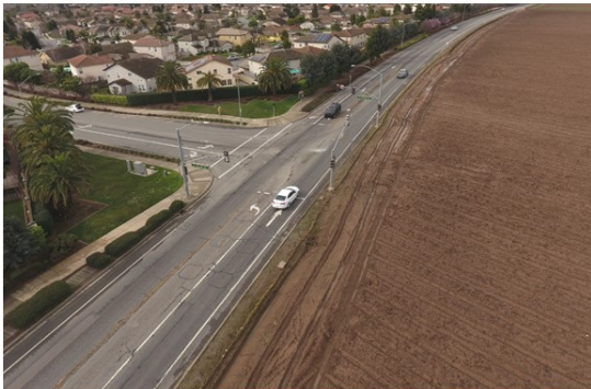
Existing El Dorado/Boronda Intersection
